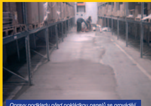
Opravy podkladu před pokládkou panelů se provádějí pouze v nutných případech.
